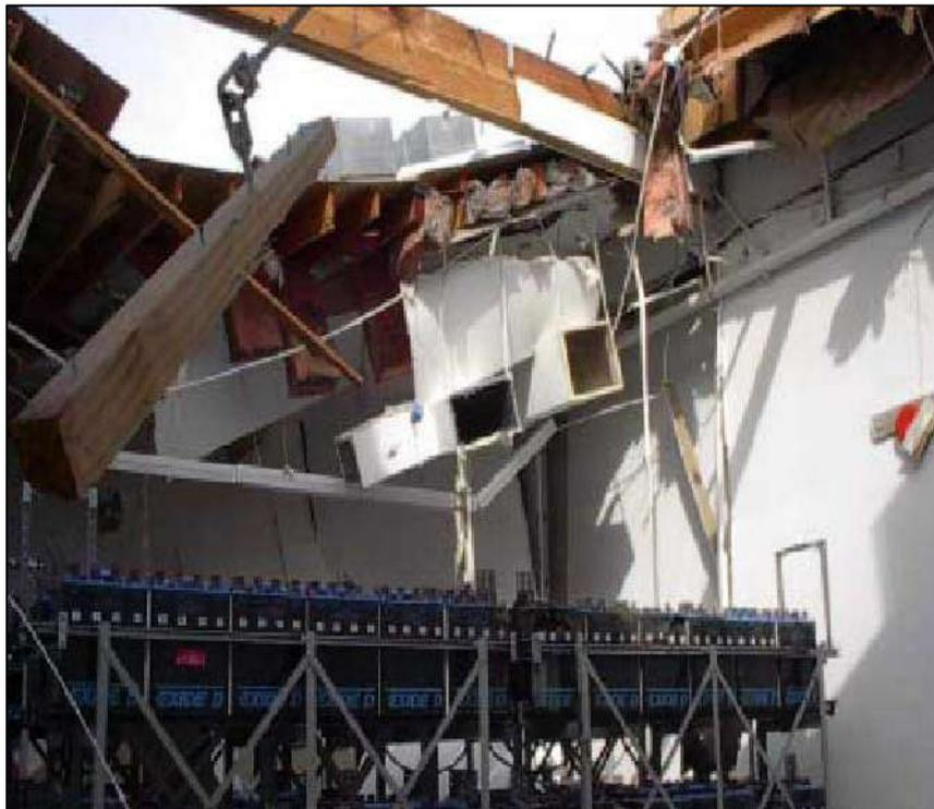
Figura 14 - Sala de baterias estacionárias com exaustão inadequada
