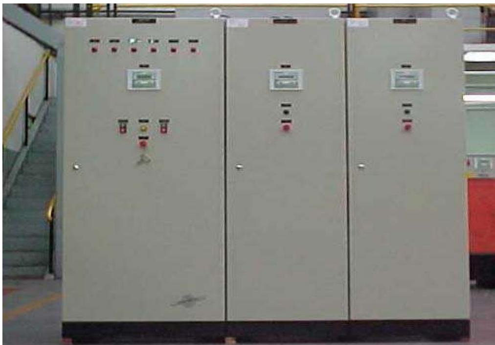
Figura 23-Vista frontal de um painel de sincronismo e paralelismo de uma “usina diesel”
