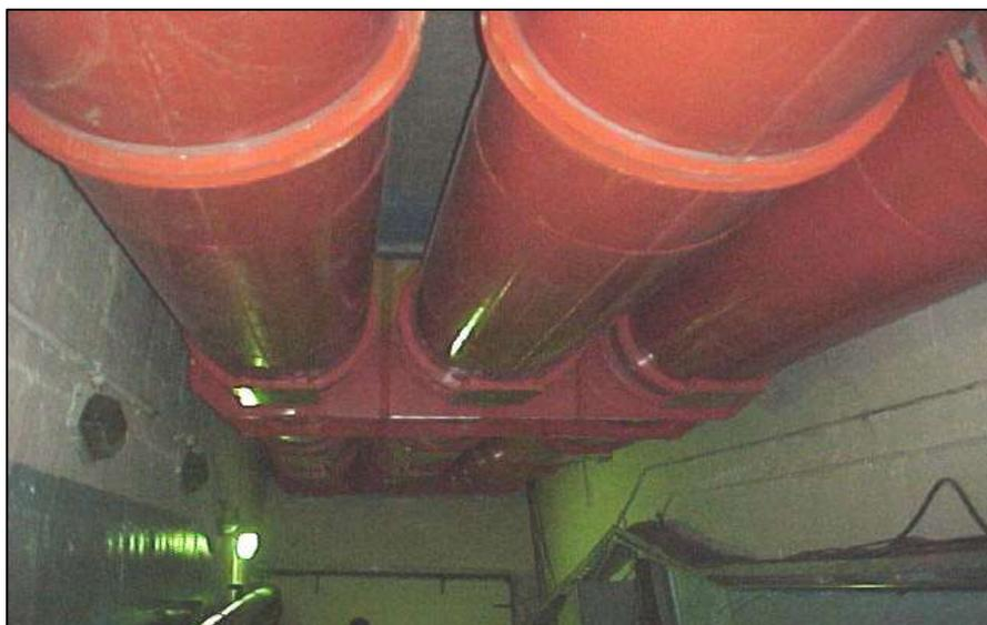
Figura 10 - Barramento blindado de fases isoladas - vista trifásica
